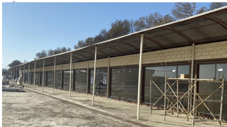
Fotosurat 1. Xarid qilish qatorining umumiy ko'rinishi; Poydevor konstruksiyalari, temir-beton karkaslar, devorlar va tomlarni tekshirishda hech qanday zarar aniqlanmadi.
