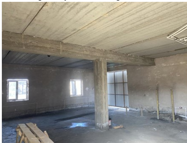
Rasm 8. Avtota'mirlash ustaxonasining umumiy ko'rinishi (1-qavat); Monolitik temir-beton karkas konstruksiyalarini tekshirish davomida hech qanday buzilishlar aniqlanmadi
